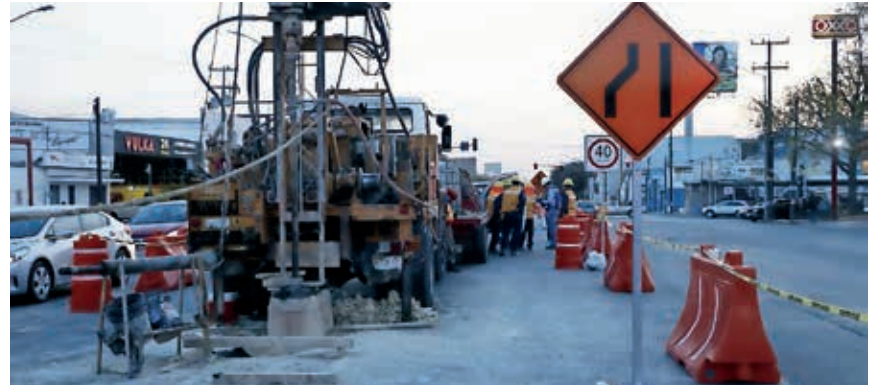
La Línea 6 del Metro será un monorriel elevado; ya inició la construcción de columnas. Foto: Especial
